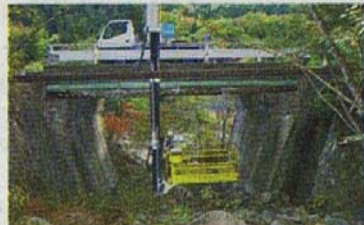
橋の点検。身近なところにある構造物をみてまわる
